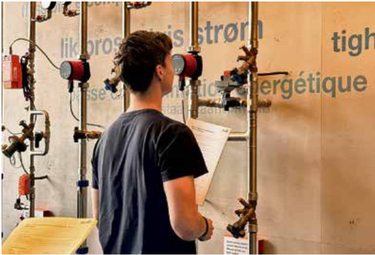
Flavio, IBZ-Student Gebäudetechnik, an der Hydraulikwand (08/26)
